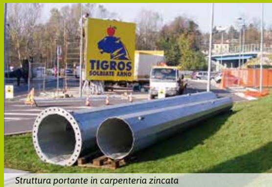
Struttura portante in carpenteria zincata
